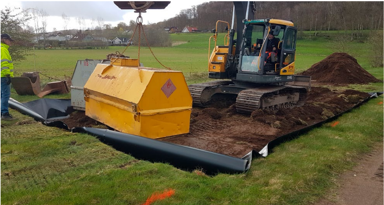
Figur 3. Förberedelse av parkeringsplats för grävmaskin i vattenskyddsområde. Foto 2024-27-03 mot sydöst. Foto Mats Nilsson.
